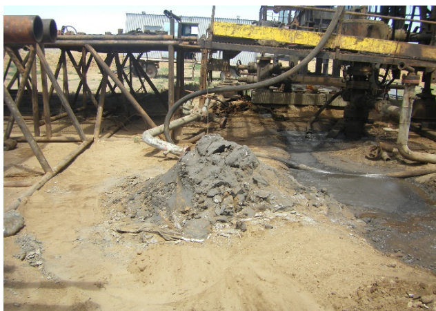
Фото 1. Капитальный ремонт скважины
